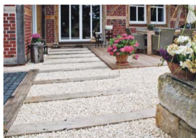
Passend dazu: Die Zuwegung mit Eichenholzbohlen.
